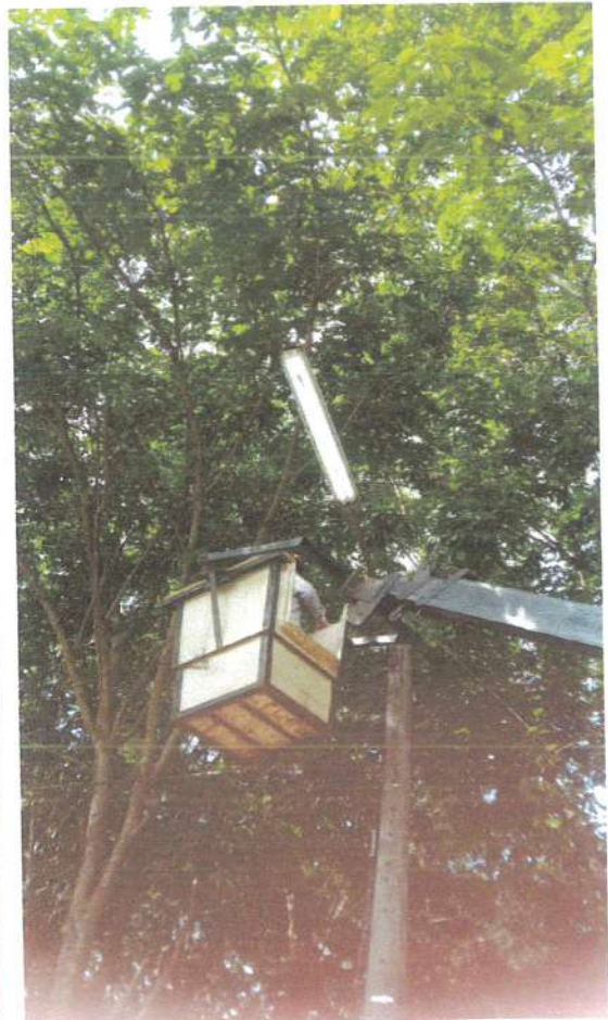
หลังดำเนินการซ่อมแซม
