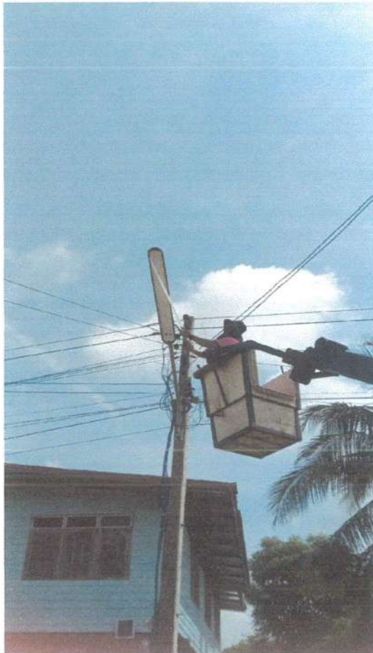
ดำเนินการซ่อมแซม
