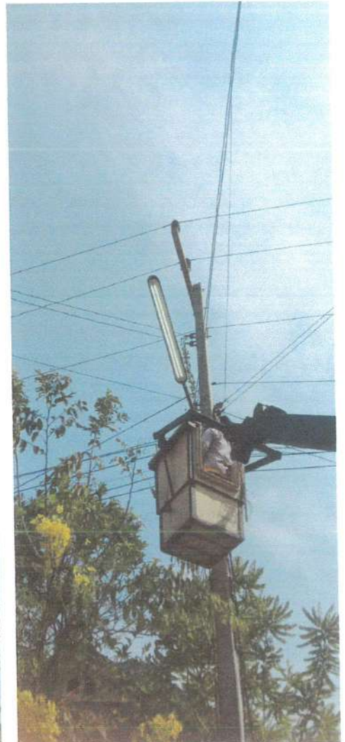
หลังดำเนินการซ่อมแซม
