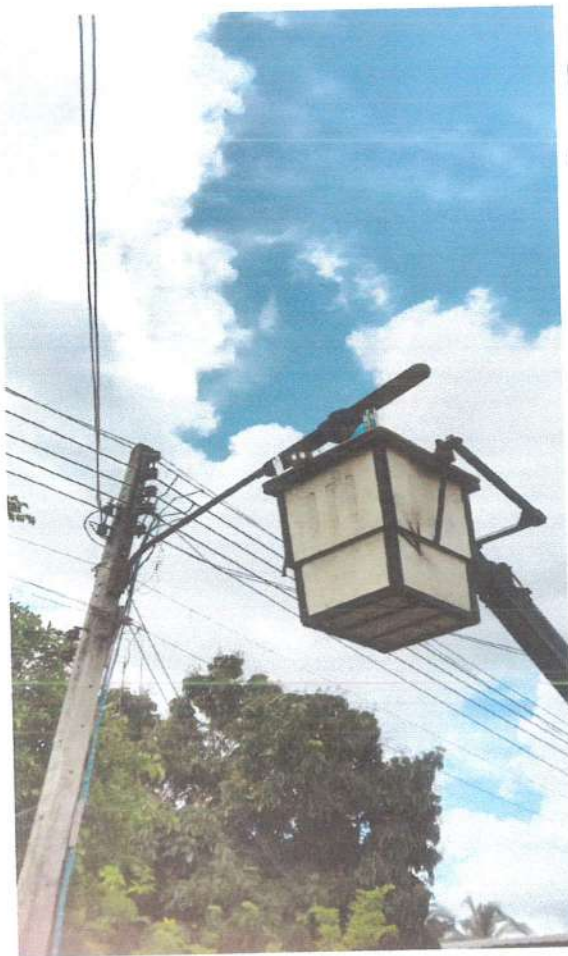
ดำเนินการซ่อมแซม
