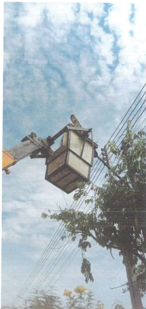
ดำเนินการซ่อมแซม
