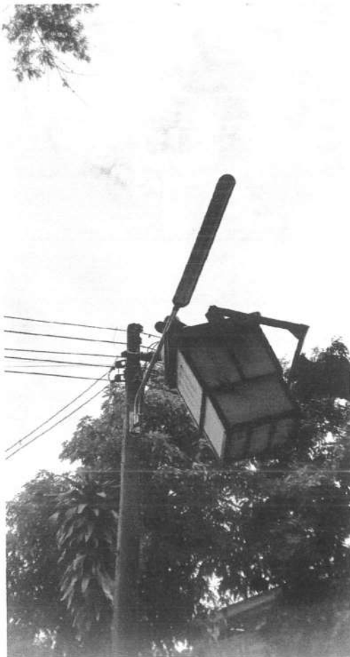
ดำเนินการซ่อมแซม
