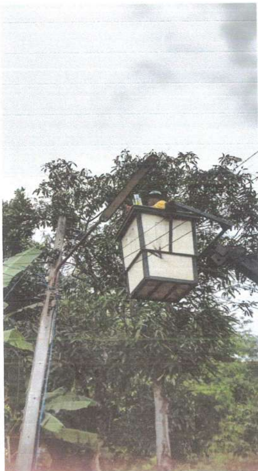
ดำเนินการซ่อมแซม
