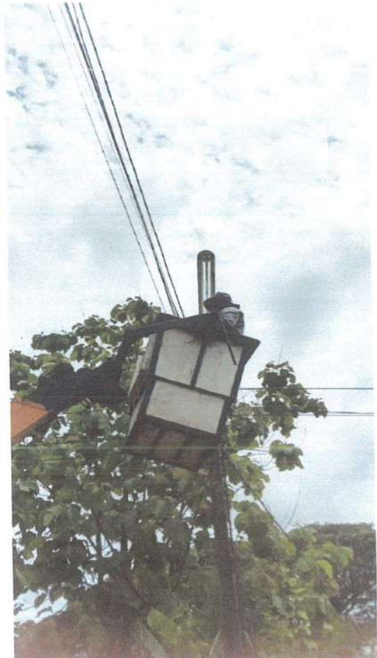
หลังดำเนินการซ่อมแซม
