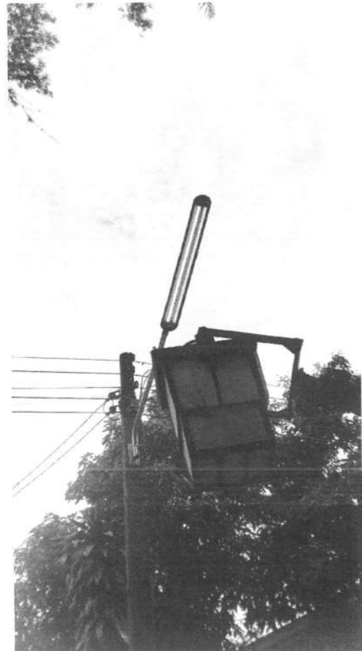
หลังดำเนินการซ่อมแซม
