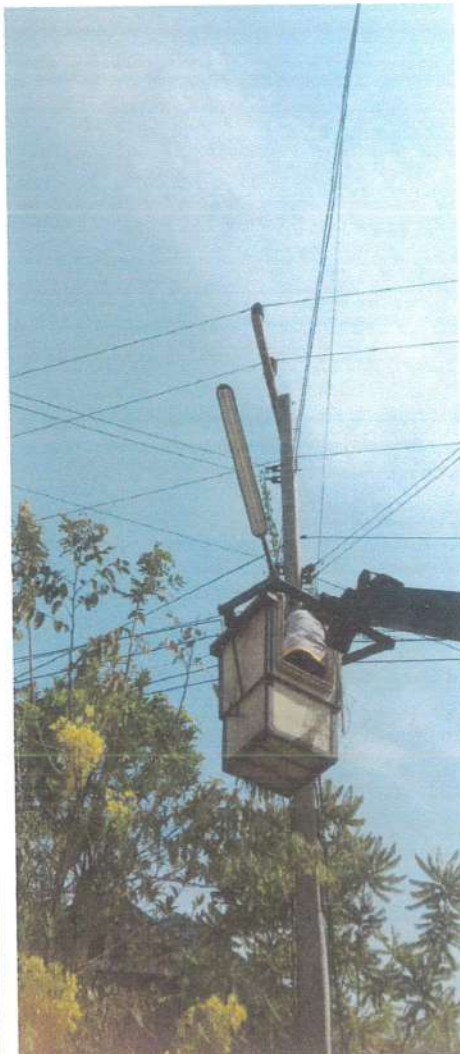
ดำเนินการซ่อมแซม
