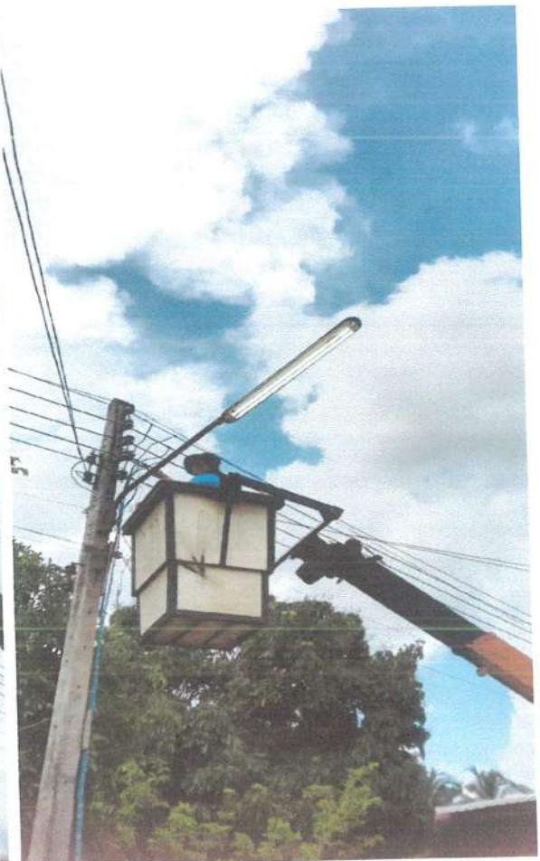
หลังดำเนินการซ่อมแซม
